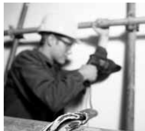
Figura 7: prima dell'uso verificare l'integrità di spine, cavi e utensili elettrici portatili.
